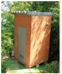
2020年3月24日に完成した山頂トイレ
